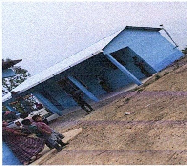
Foto 1: Fotografía de aula y cocina.
