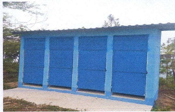
Foto 2: Fotografía de sanitarios.
